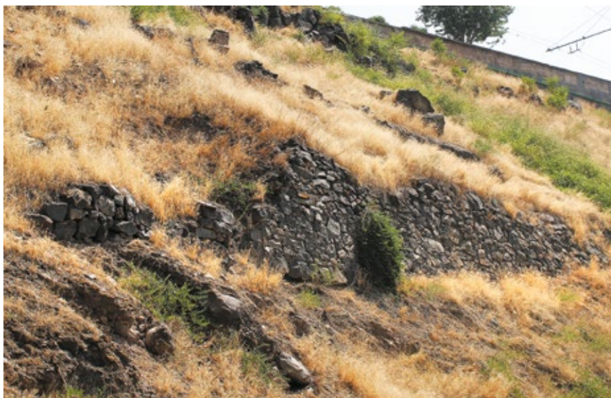
Նկ. 40. Մամոնի ջրանցքի քարաշար հատված Ս. Սարգիս եկեղեցու տակ (Source: R. Dan)
